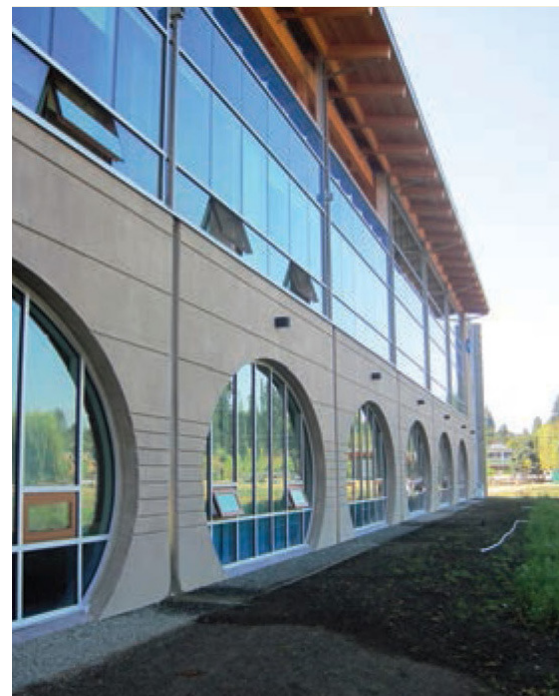
شکل ۴- پنجره‌های بازشو برای تهویه طبیعی
