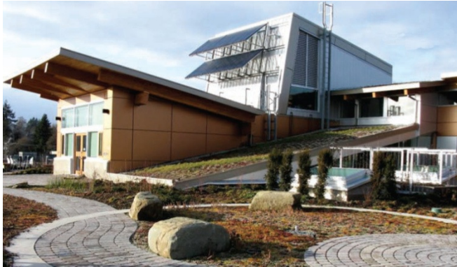
شکل ۱ - کلکتورهای خورشیدی انرژی حرارتی را تامین می‌نمایند که برای پیش گرمایش آب گرم مصرفی ساختمان مورد استفاده قرار می‌گیرد.
